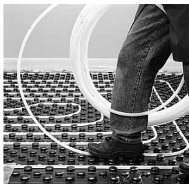
Rys.23 Sposób układania rury
